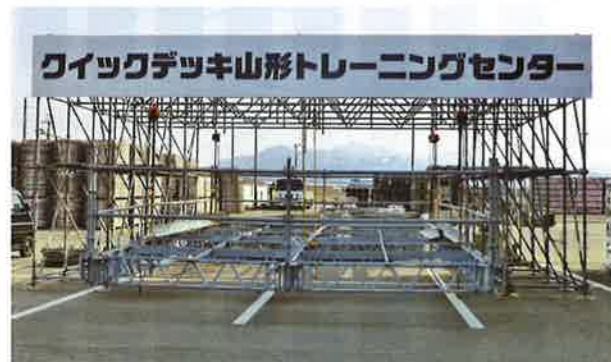
クイックデッキ工法の訓練場
