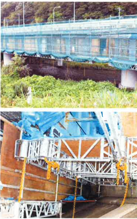
鈴地区構造物補修工事（鼠ヶ関川橋）の現場上と橋梁メンテで活躍するクイックデッキ
